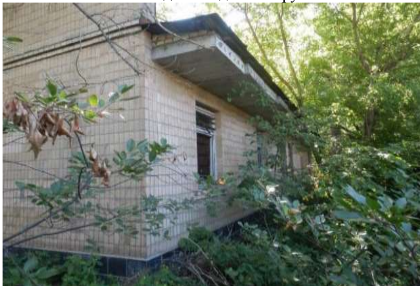
Фронтальний вид ізолятору
